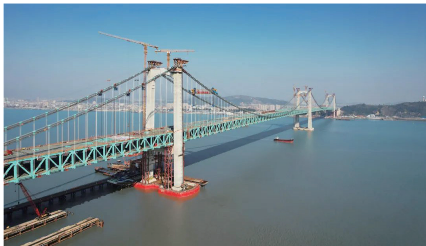
2021年12月30日，瓯江北口大桥主桥合龙
